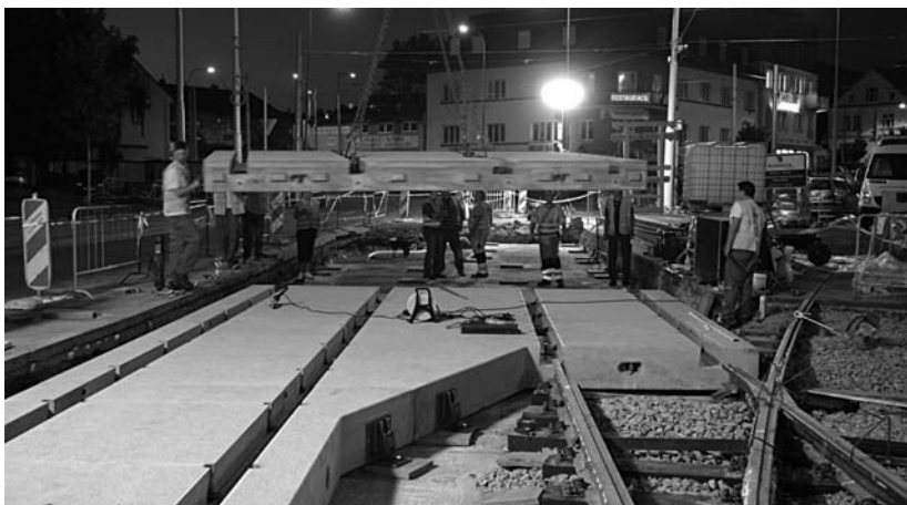
Obr. 4: Přeprava panelu na staveniště pomocí mohutného jeřábu byla složitá nejen kvůli jeho rozměrům a hmotnosti, ale i již zavěšenému trolejovému vedení.
