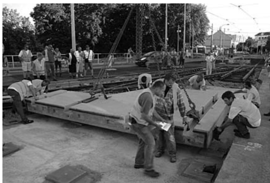
Obr. 5: V okolí již usazených panelů probíhá úprava povrchu vozovky. Druhý vrchol křižovatky není ještě dokončen, proto nejsou kolejnice v popředí propojeny.
