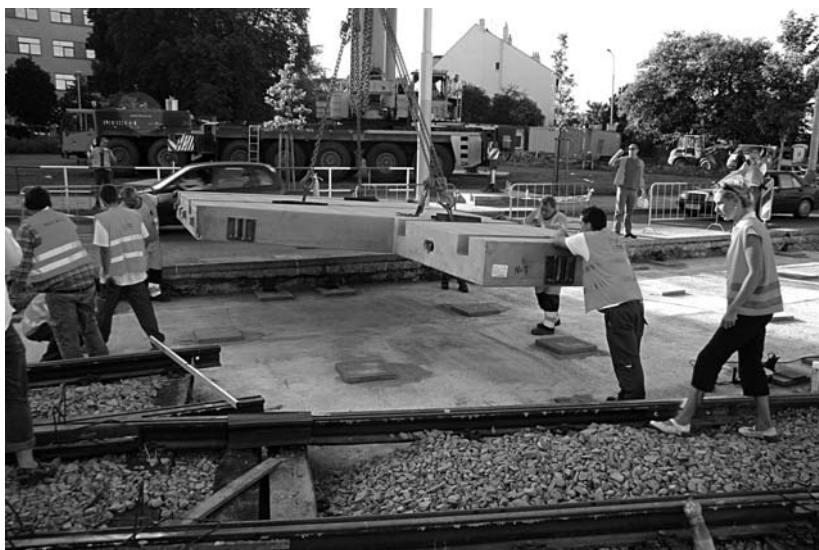
Obr. 1: Usazování prvního panelu LRB v České Republice na připravenou pláň zemního tělesa. Foto © Michal Váňa
