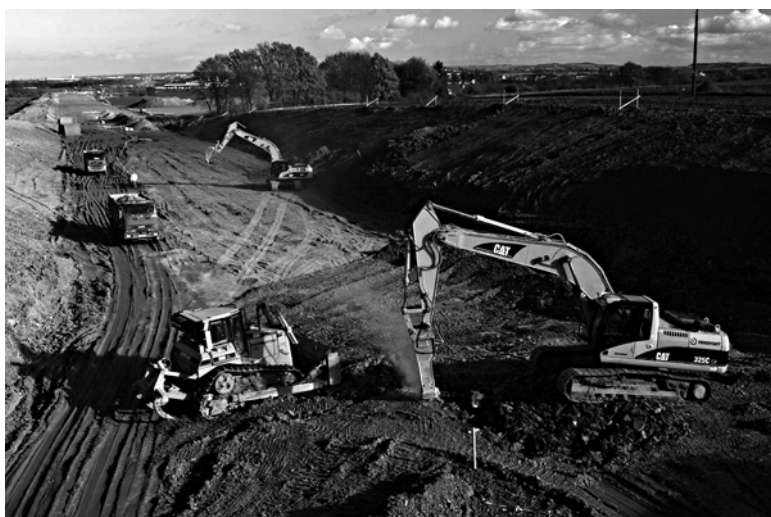
Práce v zářezu v km 2,5. Ilustrační foto © Metrostav, a. s.
