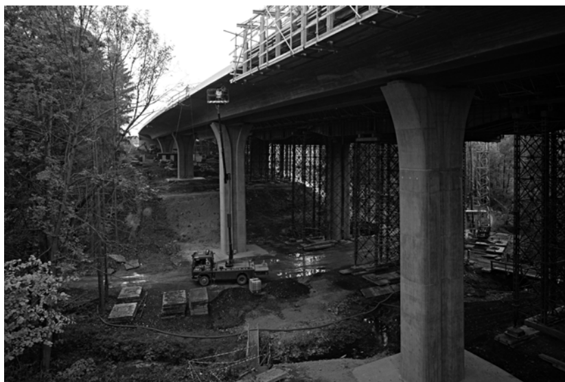
Stavba 512. Ilustrační foto © Metrostav, a. s.
