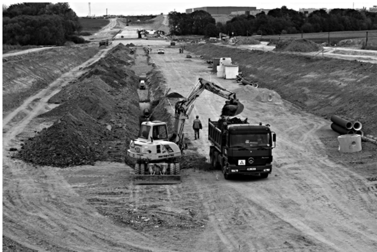
Výstavba kanalizace v km 4,5. Ilustrační foto © Metrostav, a. s.
